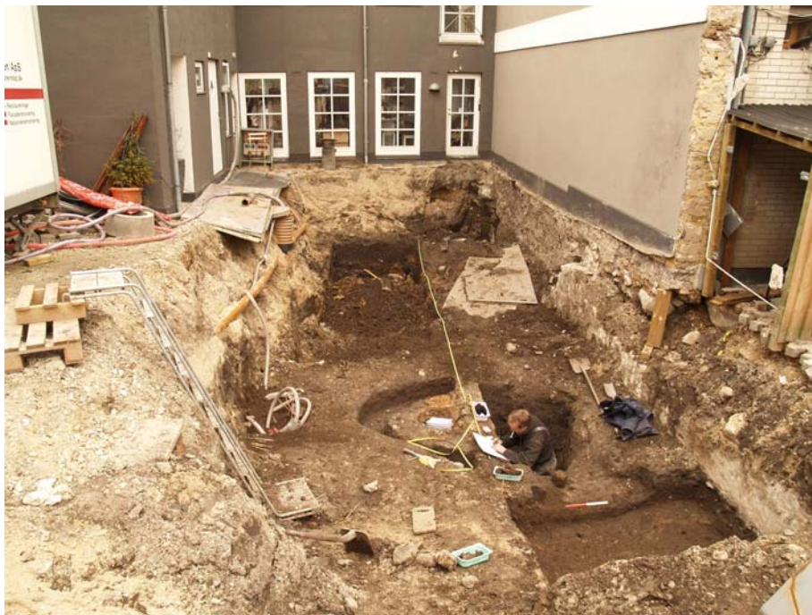
Fig. 8. Udgravningen tæt på sin afslutning ultimo marts 2007.
