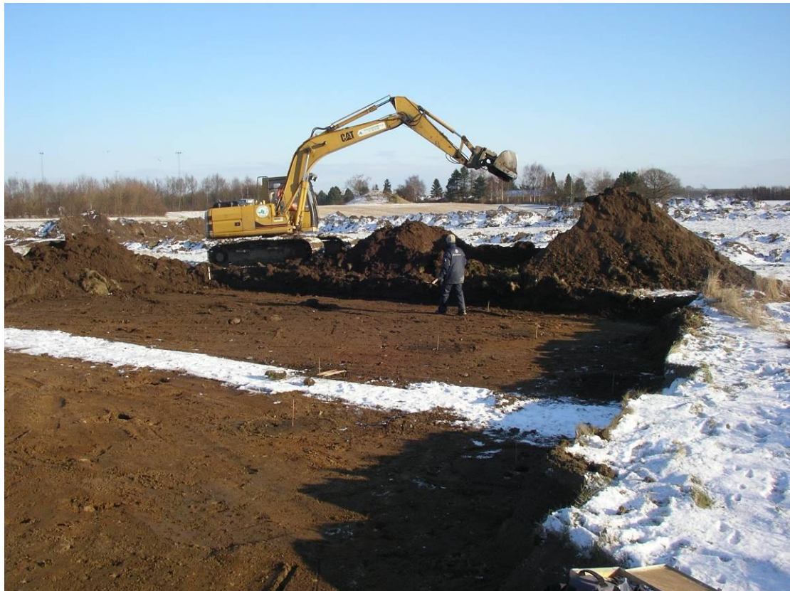
Fladeafdækning med gravemaskine.
