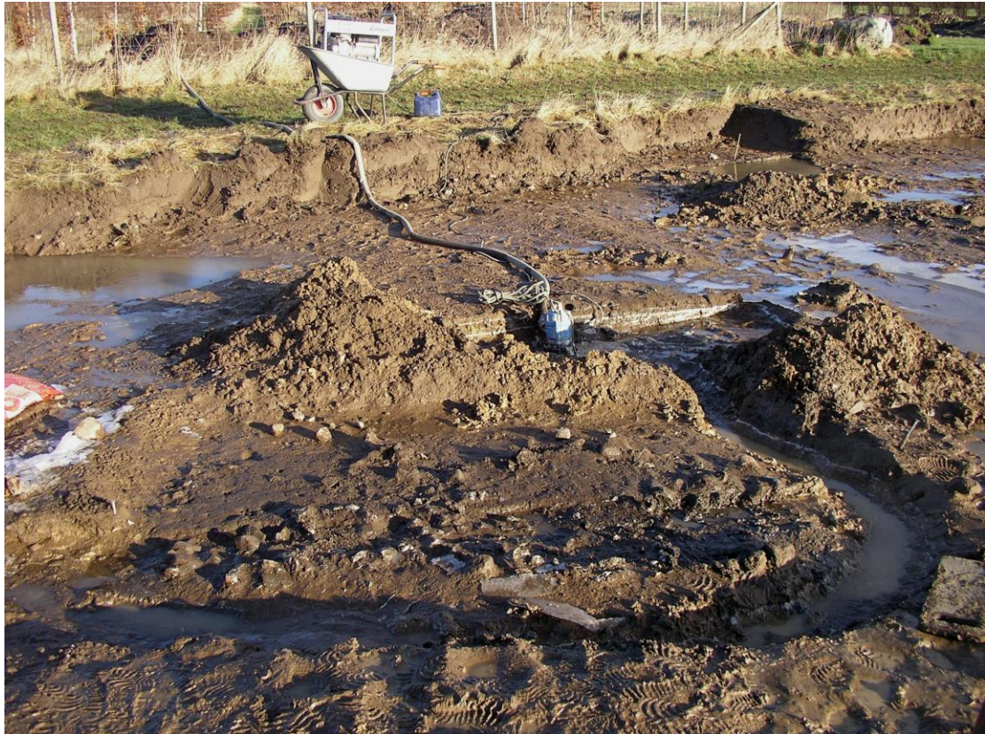
En våd dag ved Bispegårdsvej. Anlæg 5 pumpes fri for vand.
