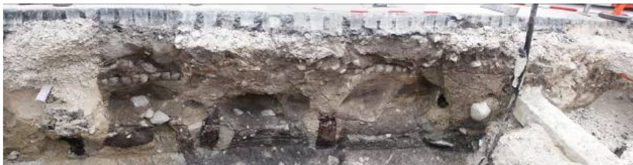
Fig. 5. Profil 1. Den østlige del af væggen i hus I. Hulningerne i grøftens side er sporene efter de store syldesten, der blev fjernet af gravemaskinen. Set fra nord.
