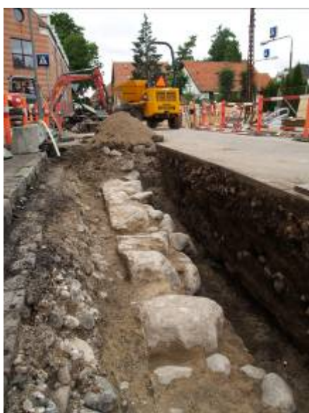
Fig. 6. Kampestensfundament til hus II. Set fra øst.
