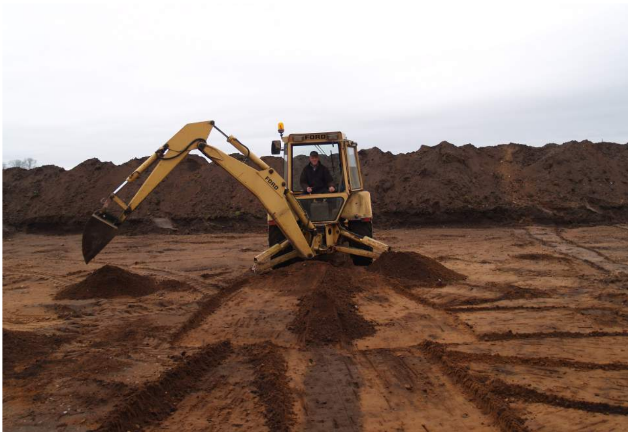
Fig. 9. Axel Nielsen afdækker en grøft med sin maskine. (Foto: Roskilde Museum.)
