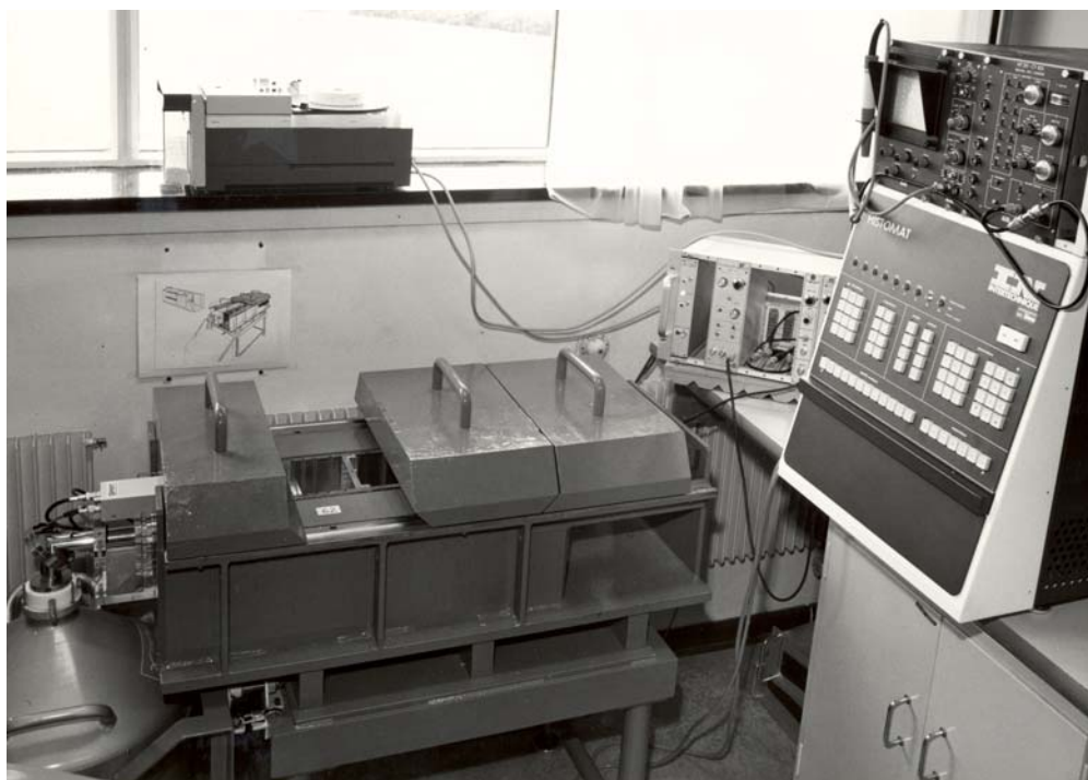
Figur 15. En af Isotoplaboratoriets måleopstillinger til aktiveringsanalytiske undersøgelser. Opstillingen kunne registrere op til 16.000 måleresultater samtidigt. Til behandlingen af disse resultater benyttede man bl.a. Risøs Borroughs B 6700 computer. Billede fra 1977. Steno Institutets Billedsamling.
