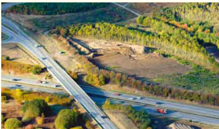
Fig. 11. Hyrdehøjskoven set fra luften en oktoberdag. Feltet, der er under tildækning efter endt udgravning, ses centralt.
