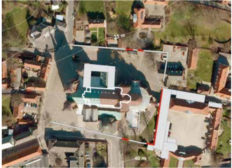
Fig. 2. Basilika og kannikekloster fra ca. 1080 er vist med lys streg. Til højre er den middelalderlige bispegård. Med rødt er angivet, hvor Arnolds muren fra ca. 1100 er påvist.
