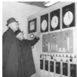
November 1966. Gasværksbestyrer A. Koue præsenterer kontrolrummet i det nye spaltegasværk for driftsbestyrer H. D. Eriksen. Foto: Henrik Clausen. Roskilde Lokallhistoriske Arkiv.
