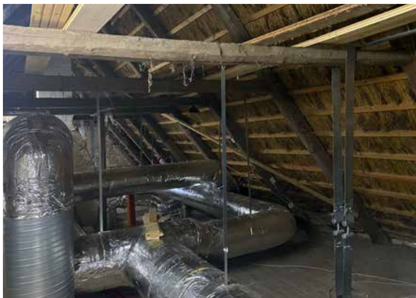
↑ Store rør og stabiliseringsløsninger er gemt væk helt oppe under stråtaget. Her er stadig lidt arbejde at gøre. Men det vigtigste var at få stabiliseret etageadskillelsen, så loftsrummet kunne bære det omfattende ventilationssystem, der er med til at skabe et godt og sundt indeklima. Foto: Lene Steinbeck.
