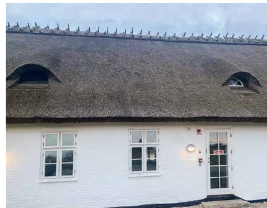
↑ Går man tæt på kvistvinduerne i det stråtækte tag, kan man se, at to af dem er forsynet med mørke jalousiriste. De skjuler luftindtag til ventilationen og sparer på den måde bygningen for synlige tegn på tilpasningen til tidens nødvendige krav. Foto: Lene Steinbeck.
